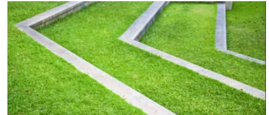
Schody na terénu
