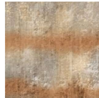
Asfalt so svetlým kamenivom
