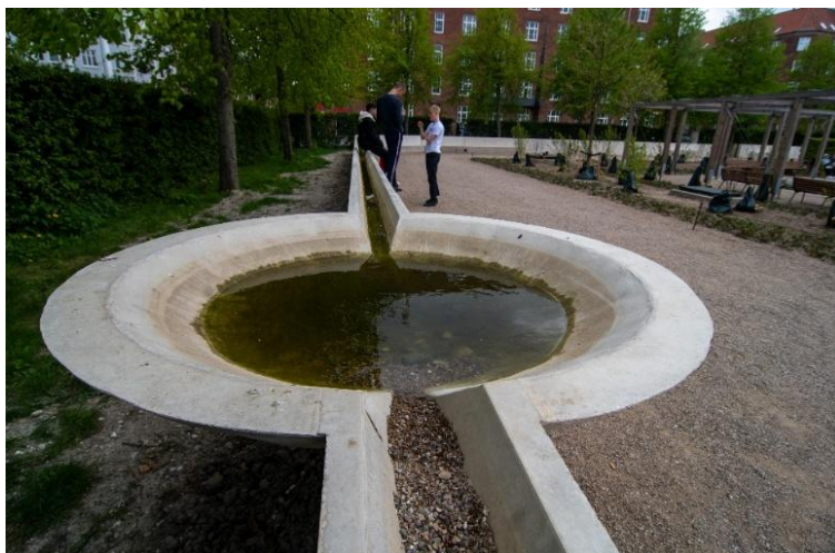
Obrázek 8: Dešťový kanál odvádějící dešťovou vodu do zeleně v Kodani, autor: Øystein Leonardsen, zdroj: The Brake Through Institute, 2021
