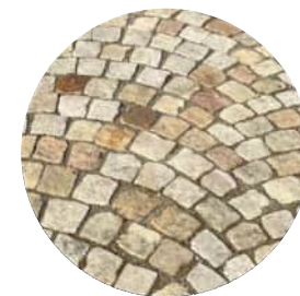
Pojízdná plocha sdílené zóny Žluté žulové kostky 10x10x10
