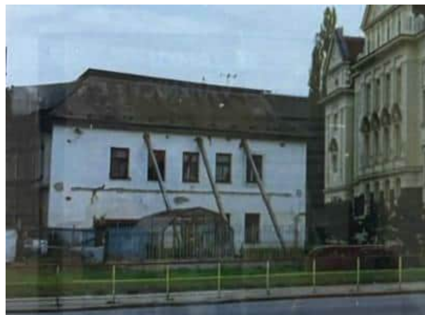
Stav před rekonstrukcí v roce 1991
