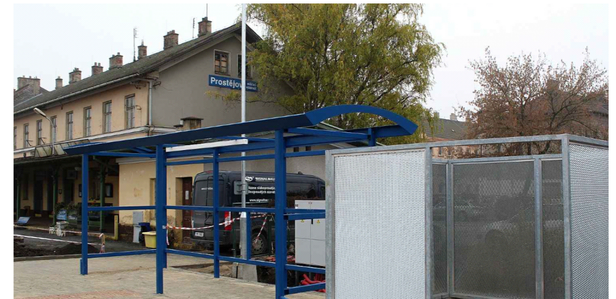
Místní nádraží instalování nové vlakové zastávky 2025
