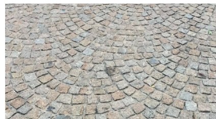
KAMENNÁ DLAŽBA, OBLOUKOVÁ zpevněné povrchy okolí objektu
