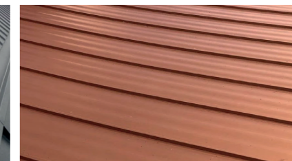
FALCOVANÝ PLECH, CIHLOVÝ střešní krytina krytého nástupiště
