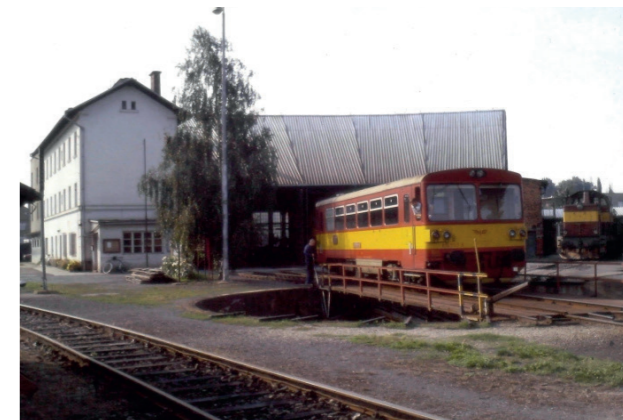
Fotografie původní točny, administrativní budovy a depa
