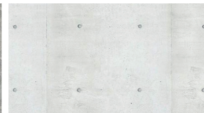
BETONOVÉ BLOKY železniční nástupiště
