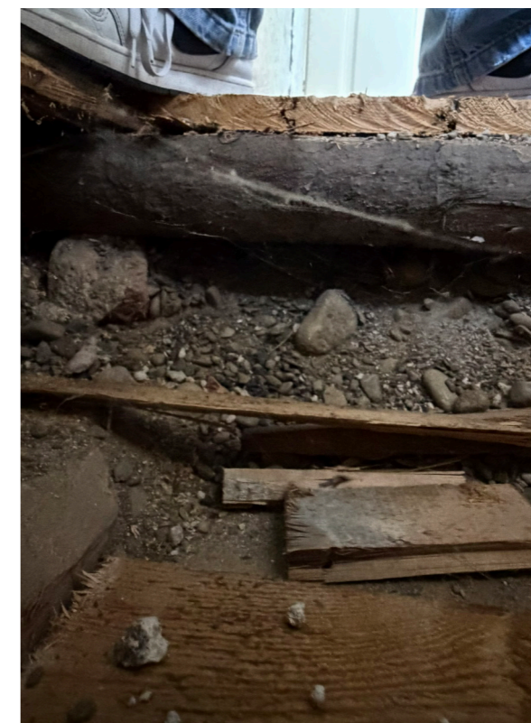
Drevený trámový strop
