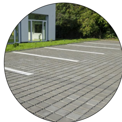
betonová vsakovací dlažba parkoviště
