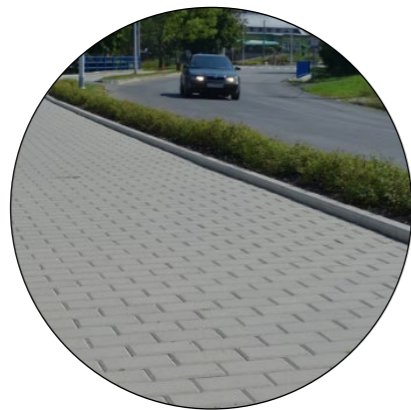
betonová dlažba hlavní chodníky
