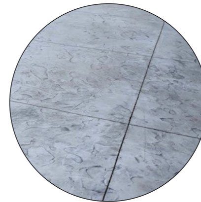
ražený beton přístup do PD
