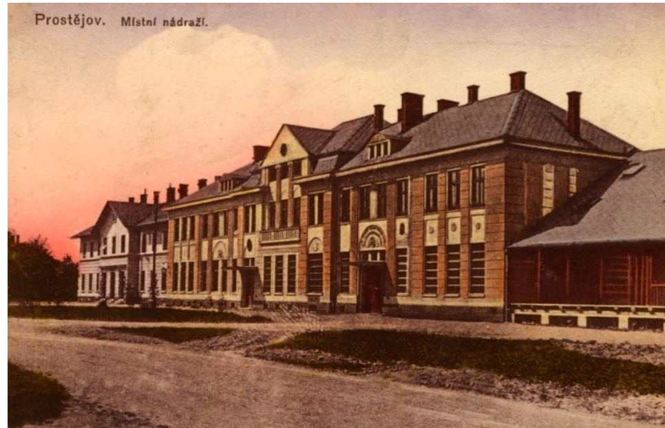
Historická budova místního nádraží Prostějov
