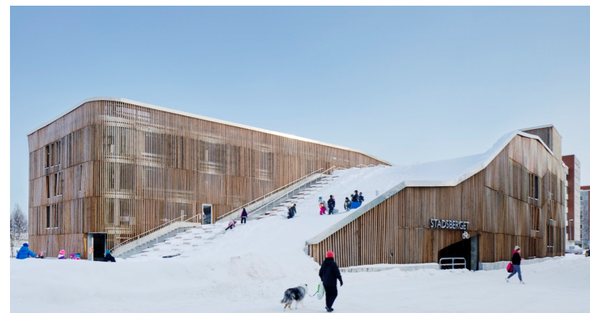
PARKING GARAGE PIETA autor: White Arkitekter + Henning Larsen Architects lokace: Pieta, Švédsko realizace: 2015
